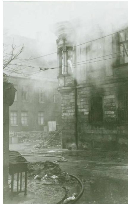
Abbildung: Brand in der Kornhausgasse Augsburg, 26.02.1944 (Foto: Feuerwehrmuseum Kaufbeuren)
