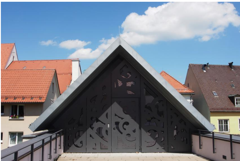
Blick auf die Dachterrasse des Stadtmuseums (Foto: Stadtmuseum Kaufbeuren)
